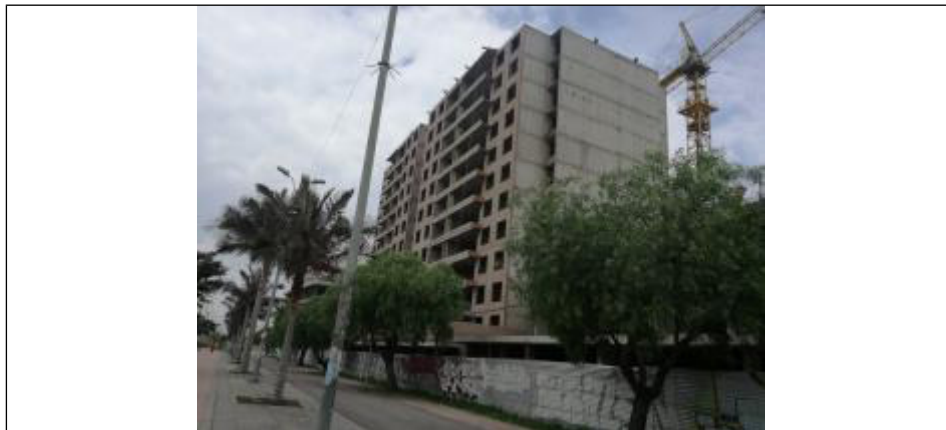
Fotografía 11. Fachada proyecto Paseo de Sevilla sin malla protectora.
