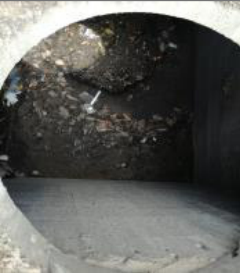
Fotografía 8 y 9. Sistema drenaje urbano ubicado en las coordenadas X: 91459.98 Y: 105395.08 colmatado por material de arrastre.
