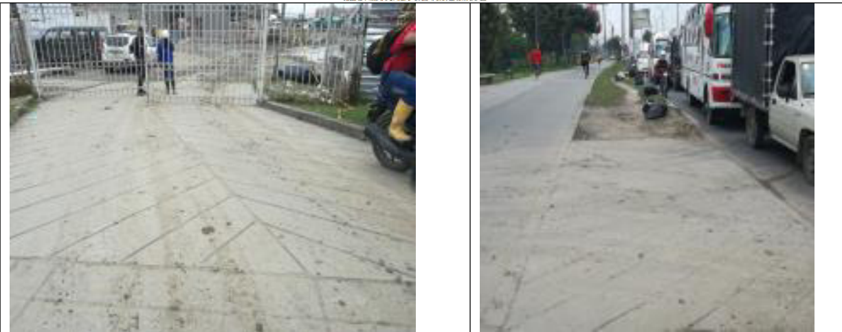
Fotografía 12 y 13. Material de arrastre sobre la vía ubicado sobre la Carrera 86 (Av. Ciudad de Cali).
