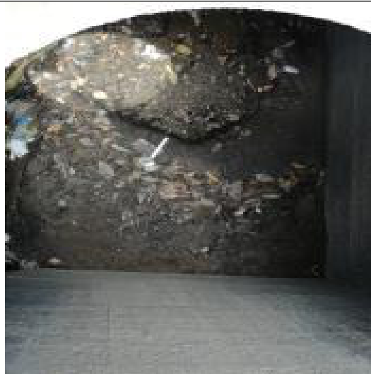
Fotografía 8 y 9. Sistema drenaje urbano ubicado en las coordenadas X: 91459.98 Y: 105395.08 colmatado por material de arrastre.
